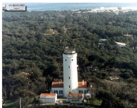
Sémaphore: Surveillance des passes d'accès du bassin d'Arcachon
